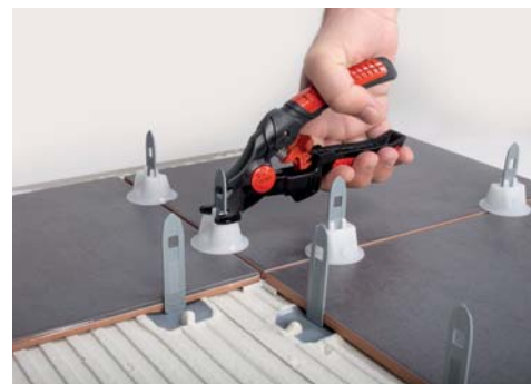
Fot. 5. System do poziomowania płytek firmy RUBI
