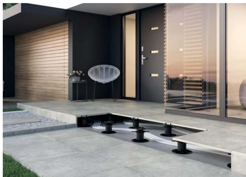
Fot. 4. Przykład montażu płytek gresowych o grubości 20 mm na wspornikach
