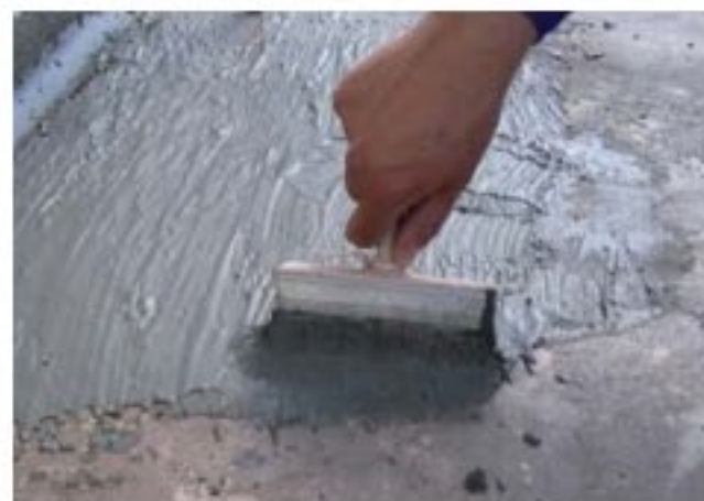
Wykonując izolację podpłytkową należy zaprawę uszczelniającą nanieść dwuwarstwowo
