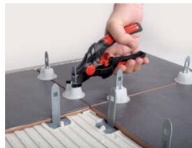
Fot. 4. System do poziomowania płytek ceramicznych TILE LEVEL QUICK
