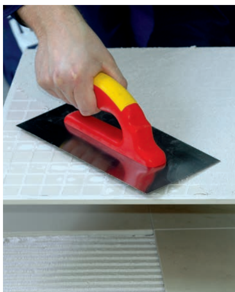
W metodzie kombinowanej zaprawę klejącą na spodnią stronę płytki ceramicznej nanosi się prostą krawędzią pacy
